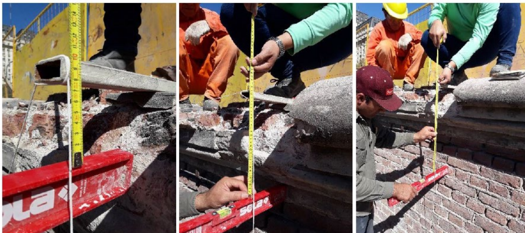
Replanteo de nivel de piso terminado.
