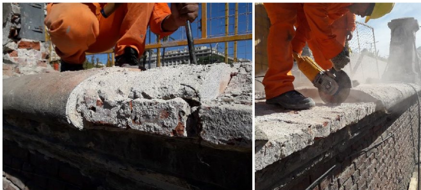
Remoción manual de revoques y corte de mampostería con amoladora.
