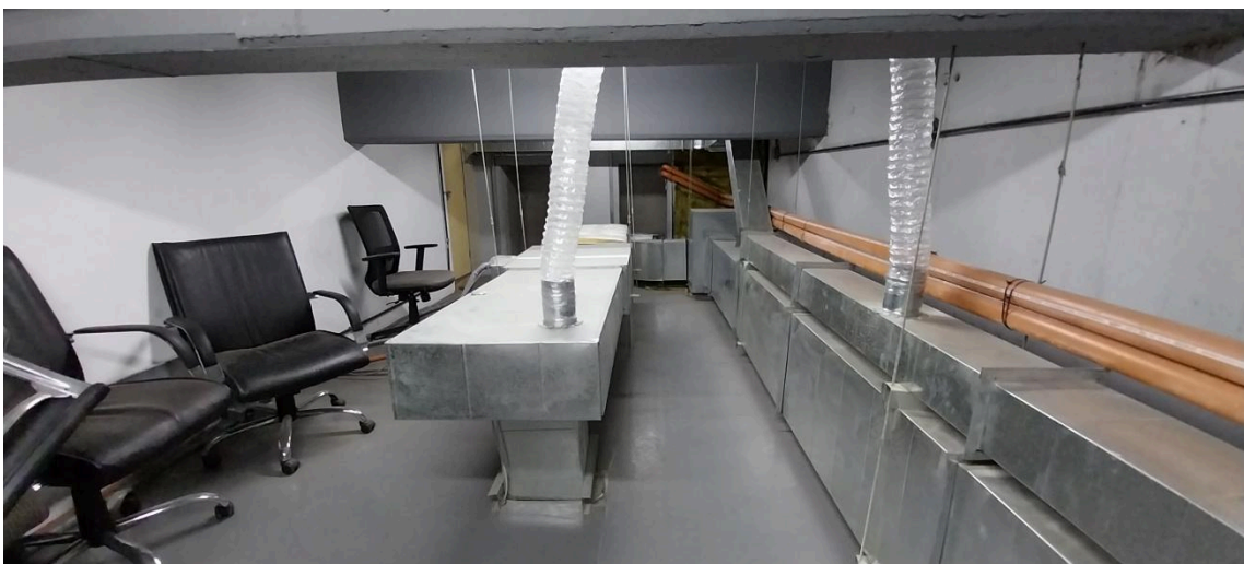
Entrepiso depósito e instalaciones de aire acondicionado
